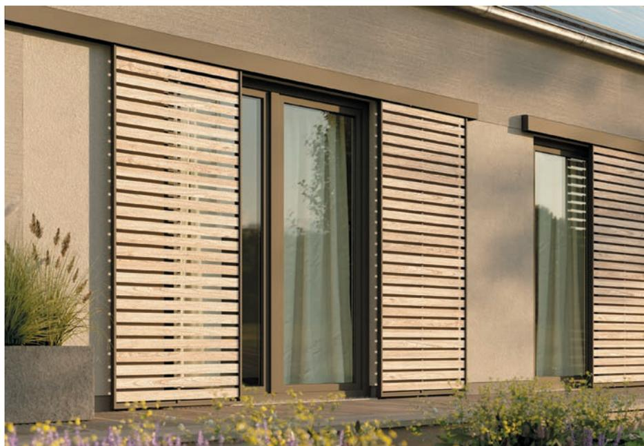
>>> **Schiebeläden:** Ebenfalls für Verdunklung und Sichtschutz sorgen die Schiebeläden, welche dank einer auf der Fassade sichtbar aufgesetzten Laufschiene auf- oder zugleiten. Auch diese sind in den Varianten „SUN“ oder „NATURE“ erhältlich.
